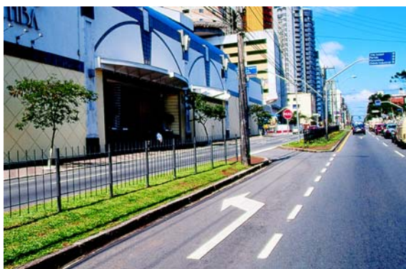
EMPREENDIMENTO: Supermercado Big, Curitiba / PR SERVIÇO: Remanejamentos em duas vias transversais (com pavimentação de uma delas); sinalização semafórica com fase para o pedestre; implantação de uma via marginal paralela a via principal
