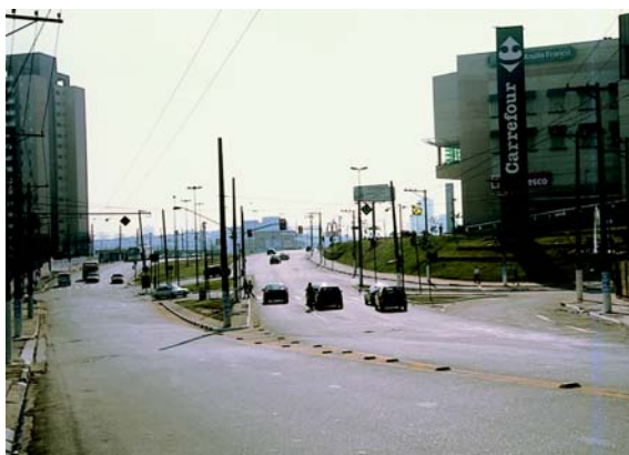
EMPREENDIMENTO: Shopping Anália Franco, São Paulo / SP SERVIÇOS: Duplicação da Av. Regente Feijó (adequação do acesso principal ao Shopping Anália Franco) sinalização semafórica e horizontal
