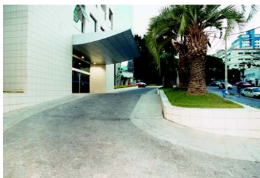
EMPREENDIMENTO: Life Center (Complexo Médico Hospitalar Vertical), Belo Horizonte / MG SERVIÇOS: Área especial para embarque e desembarque de clientes fora da via pública
