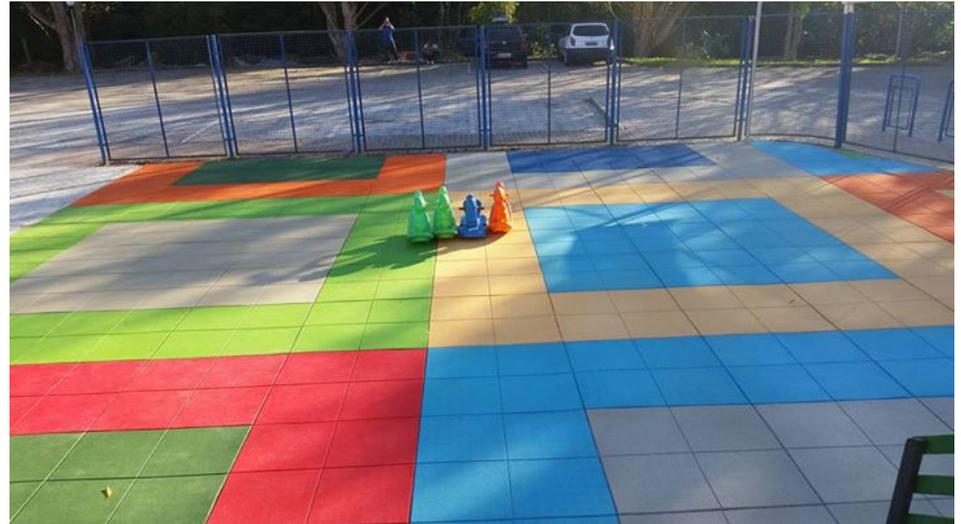
**Nas áreas externas serão instalados piso em concreto permeável (drenante), piso emborrachado composto por grânulos de borracha reciclada prensada, e deck em madeira plástica (material reciclado).**
