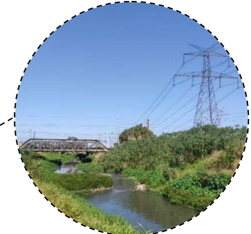
1. TORRES DE ALTA TENSÃO FAIXA NON AEDIFICANDI
