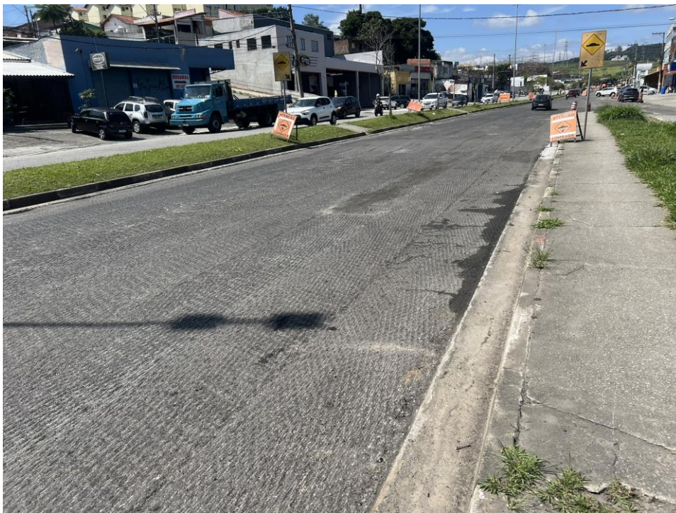
Fotografia 23: Avenida Prefeito Francisco Ribeiro Nogueira
