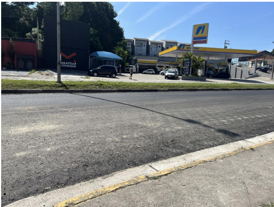
Fotografia 18: Avenida Prefeito Francisco Ribeiro Nogueira
