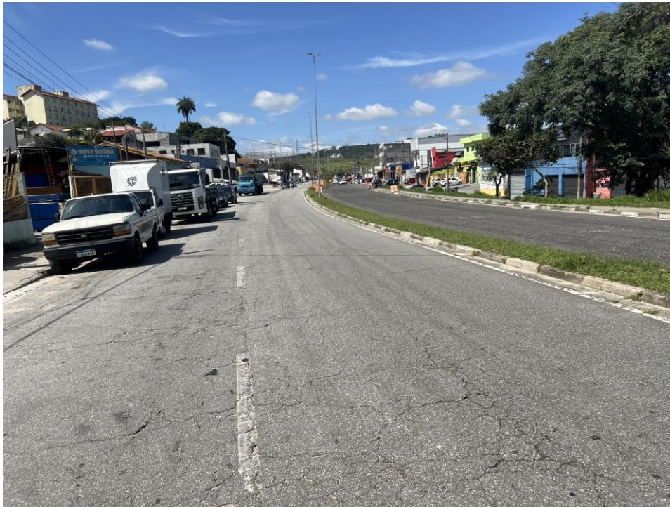
Fotografia 21: Avenida Prefeito Francisco Ribeiro Nogueira
