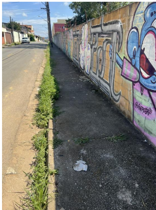
Fotografia 7: Rua Oscar Tompson – Detalhe da Calçada do Logradouro
