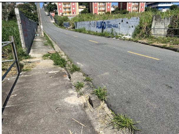
Levantamento fotográfico 11: Rua Gomes Cardim
